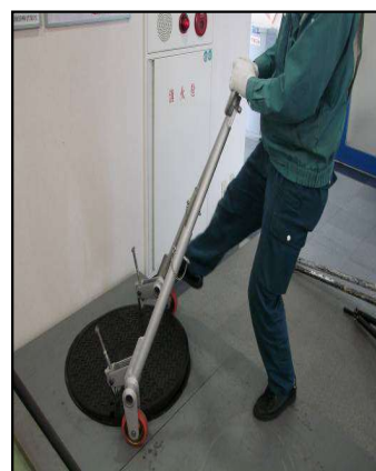
③左方向に回転させ、鉄蓋のロック解除する
